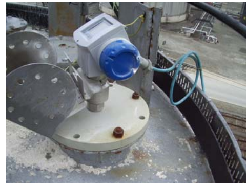
OPTIFLEX zur Kalkfüllstandmessung in einem Silo
